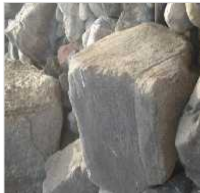
Photo n° 11 : détail d'une base de colonne
